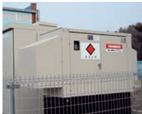
非常用自家発電装置（大和工場）
