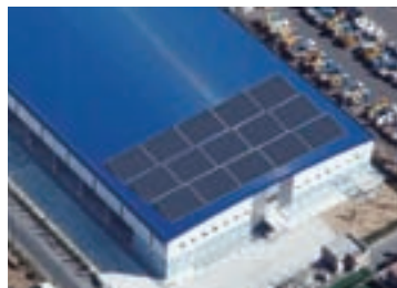
東京物流センターの太陽光パネル
