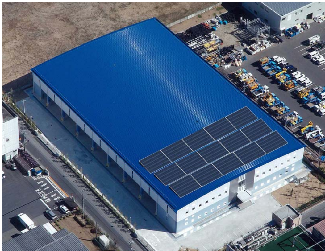
太陽光パネル
